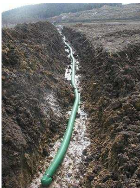
Lavori di drenaggio nell'impianto vigneto realizzato nella primavera del 2006
