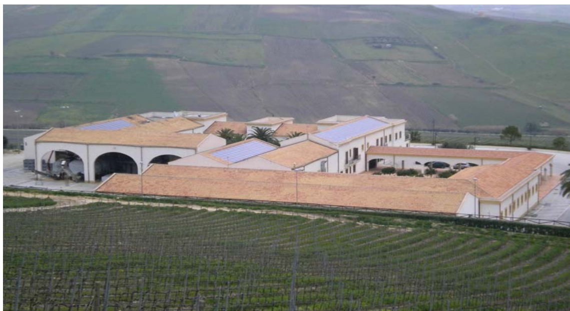
Fotografia dell'impianto fotovoltaico a febbraio 2010 sul tetto di Feudo Arancio.
